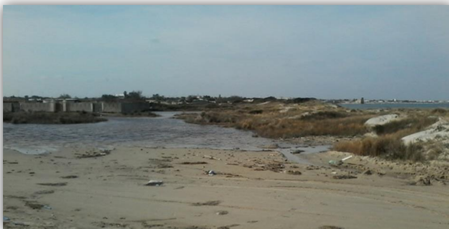
Figura 59. Rischio idrogeologico. Macroarea di rischio MRA_012 Marine. Zona soggetta ad allagamenti in località Torre Rinalda (fonte Comune di Lecce – Relazione geologica dott. S. Margiotta).
