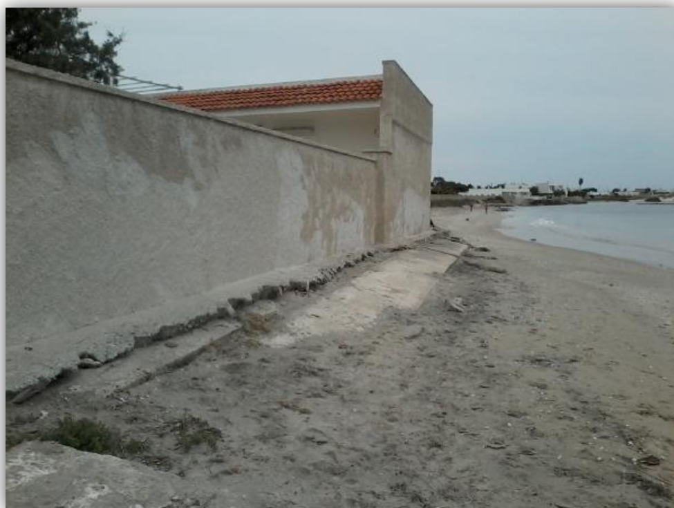
Figura 75. Rischio geomorfologico. Esempio di fenomeni di dissesto in atto in località Spiaggiabella (fonte Relazione sulla Pericolosità Idraulica e Geomorfologica del Geol. S. Margiotta).
