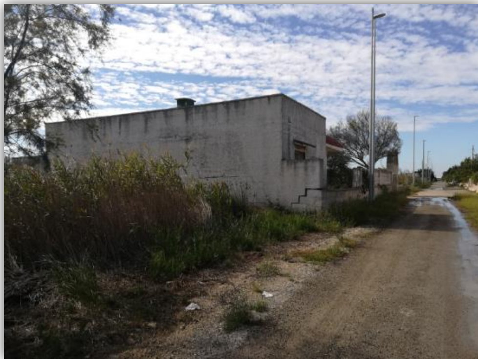
Figura 74. Rischio geomorfologico. Esempi di abitazioni che mostrano chiari fenomeni di dissesto in località Torre Rinalda (a) e Spiaggiabella (b) ubicate nella parte interna del territorio costruito (fonte Relazione sulla Pericolosità Idraulica e Geomorfologica del Geol. S. Margiotta).
